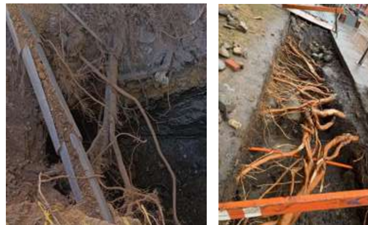
Excavación manual para proteger raíces
