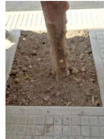
Reposición de tierra correcto en alcorque de nueva construcción
