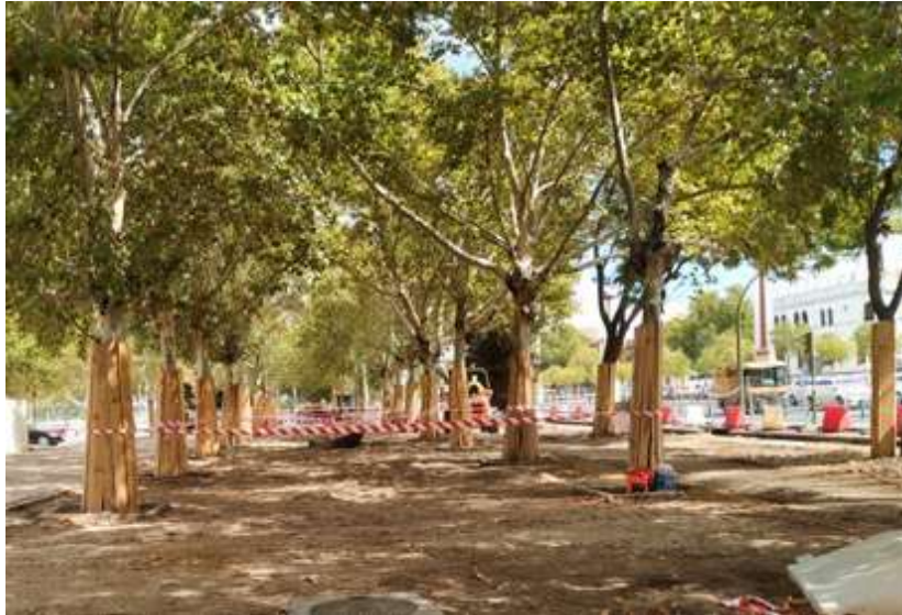
Señalización de las vías para el tránsito de maquinaria
